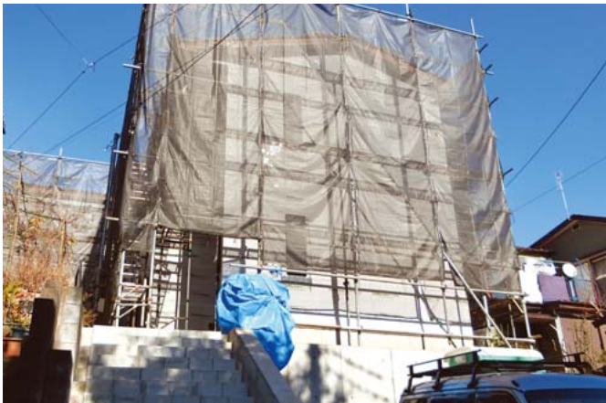
▲夢花事業部の生活ホーム建築現場
